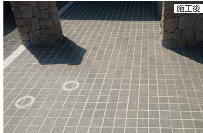
施工後 アプローチにあった無機質の蓋が枠だけになり見た目もスッキリとしました。
